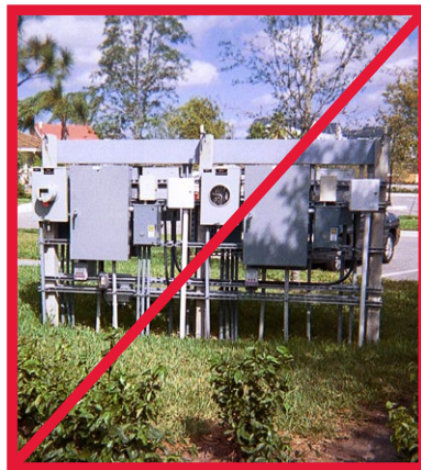
Puntal y tablero
